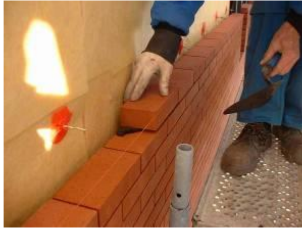
Voorbeelden van de verwerking bij alle stenen, behalve de hardere stenen.
