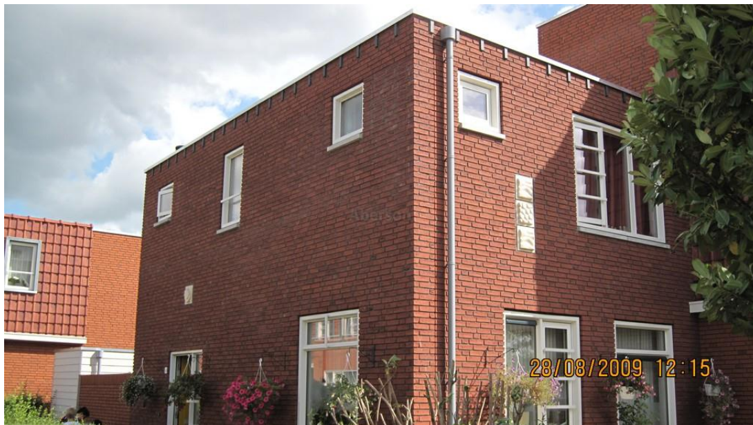
Renovatie project van 700 woningen in Almere – 70 mm steen, doorstrijkmethode, 3-5 mm verdiept
