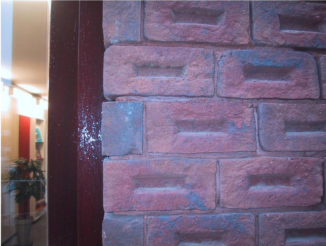
Hoekoplossing met een aangepast verband
