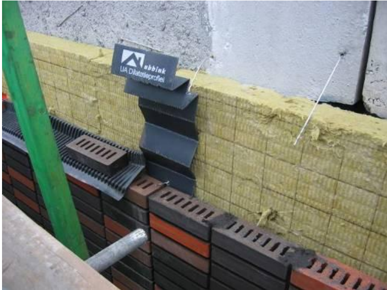
Voorbeeld van een U-A dilatatieprofiel
