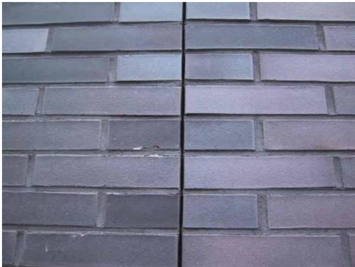
Voorbeeld van een 3mm 1 open dilatatie
