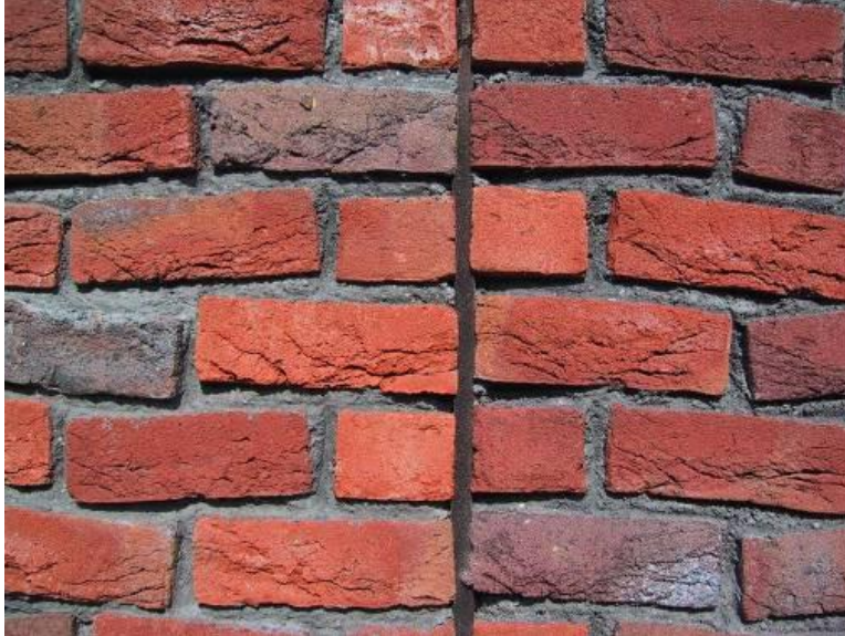
Voorbeeld van een voeg met een gecprimeerde zicht band
