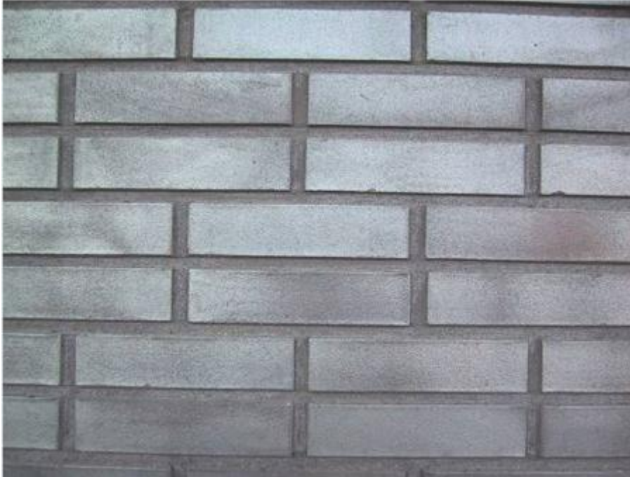
Zwolle, kantoorpand Dr. Deenweg: De voegen zijn afgewerkt met een voegijzer en er zijn "platvolle" gladde voegen gemaakt.
