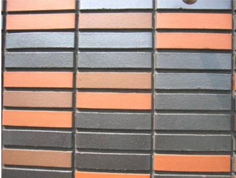
Utrecht, Diergeneeskunde gebouw: een 10 mm terugliggende glad uitgevoerde voeg.
