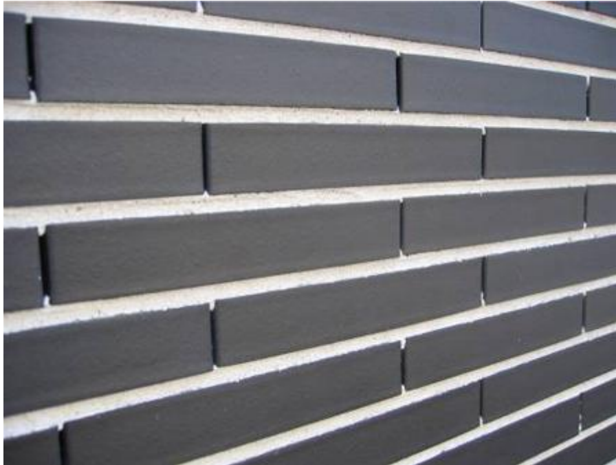
Amsterdam, appartementen aan de Bloedstraat: Lintvoegen 5 mm. terugliggend en glad met open stootvoegen van 6 mm.
