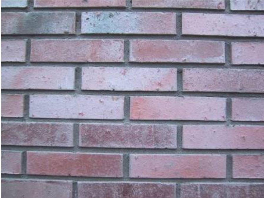
Apeldoorn, hoofdkantoor van de ABN-AMRO bank aan de Wapenrustlaan. Een 10 mm. verdiepte “sinaasappelstructuur” met een donkere voeg.
