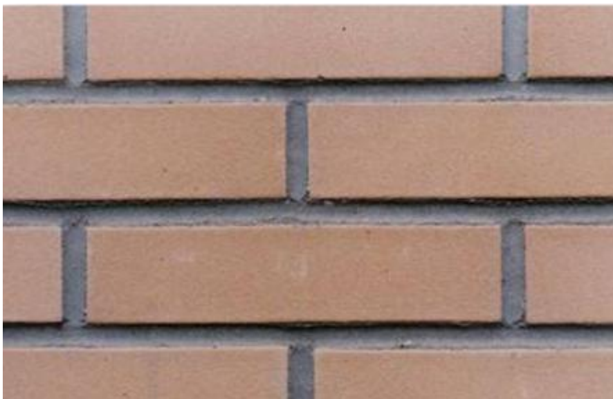
Hoogkerk, vrijstaande woningen: De voegen zijn hier afgewerkt met een pointmaster met een ijzer waardoor een holle gladde voeg is ontstaan.
