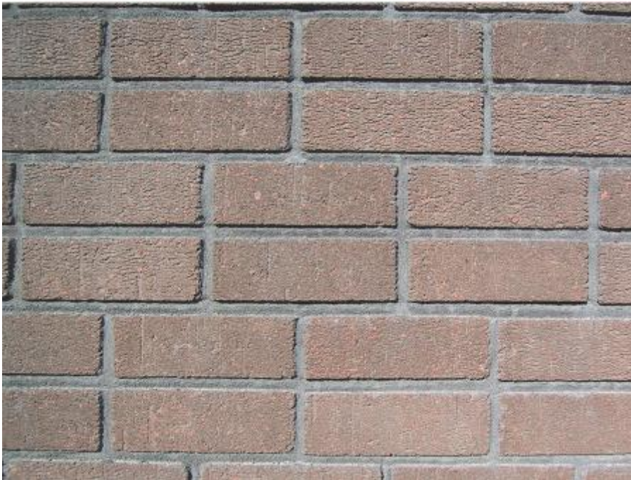
Deventer, appartementen Pothoofd.
