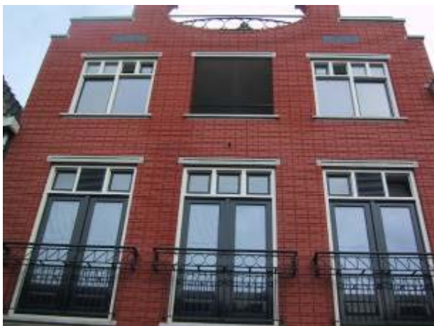
Het 1 e project in Nederland: De Koestraat in Amersfoort met een 7 m.m. stoot en lintvoeg met een rode „dunbed mortel “ en strengpersstenen in de modulformaten 40 en 90 mm.
