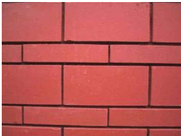
Het 1 e project in Nederland: De Koestraat in Amersfoort met een 7 m.m. stoot en lintvoeg met een rode „dunbed mortel “ en strengpersstenen in de modulformaten 40 en 90 mm.
