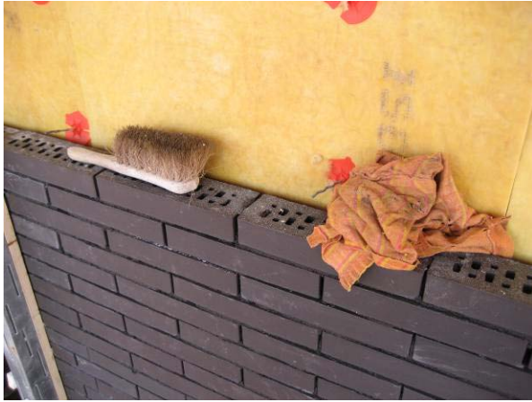
Voorbeelden van de dunbedmortelmethode bij hardere en smallere stenen.
