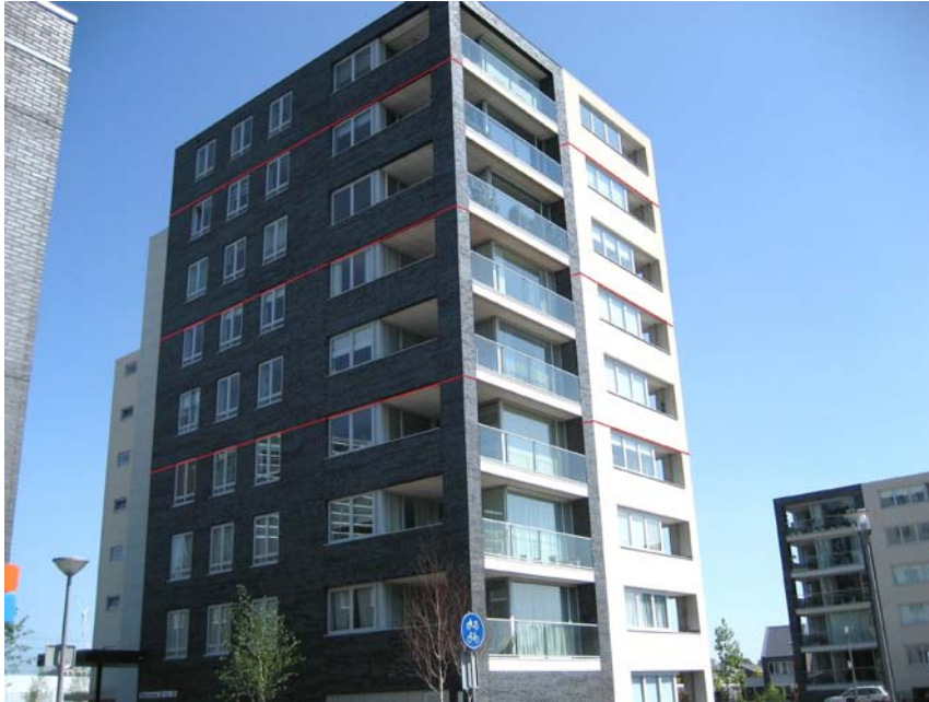
Voorbeeld: Appartementen gebouw met een betonnen binnenmuur – vanaf de fundering 4 verdiepingen en daarboven om de 2 verdiepingen.
