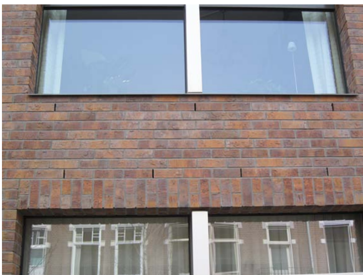
Voorbeeld van een goede situering van de open stootvoegen.
