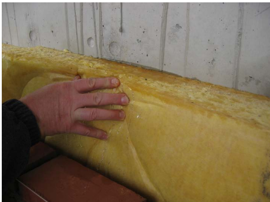
Natte isolatie bij een te kleine open spouw. Wij adviseren om de laatste 3 zinnen uit de 2 e alinea van de NPR 2652 blad 3 – zie bijlage – niet voor waarheid aan te nemen.
