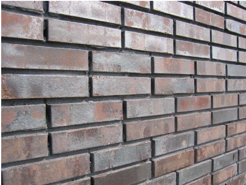
Voorbeeld van een 2 steens blokverband.
