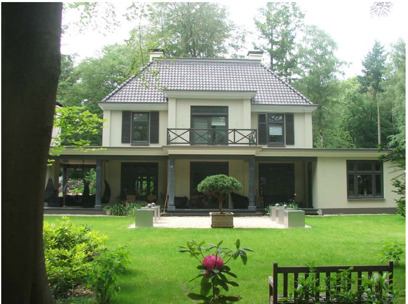
Voorbeeld van gestukadoorde buiten gevels.
