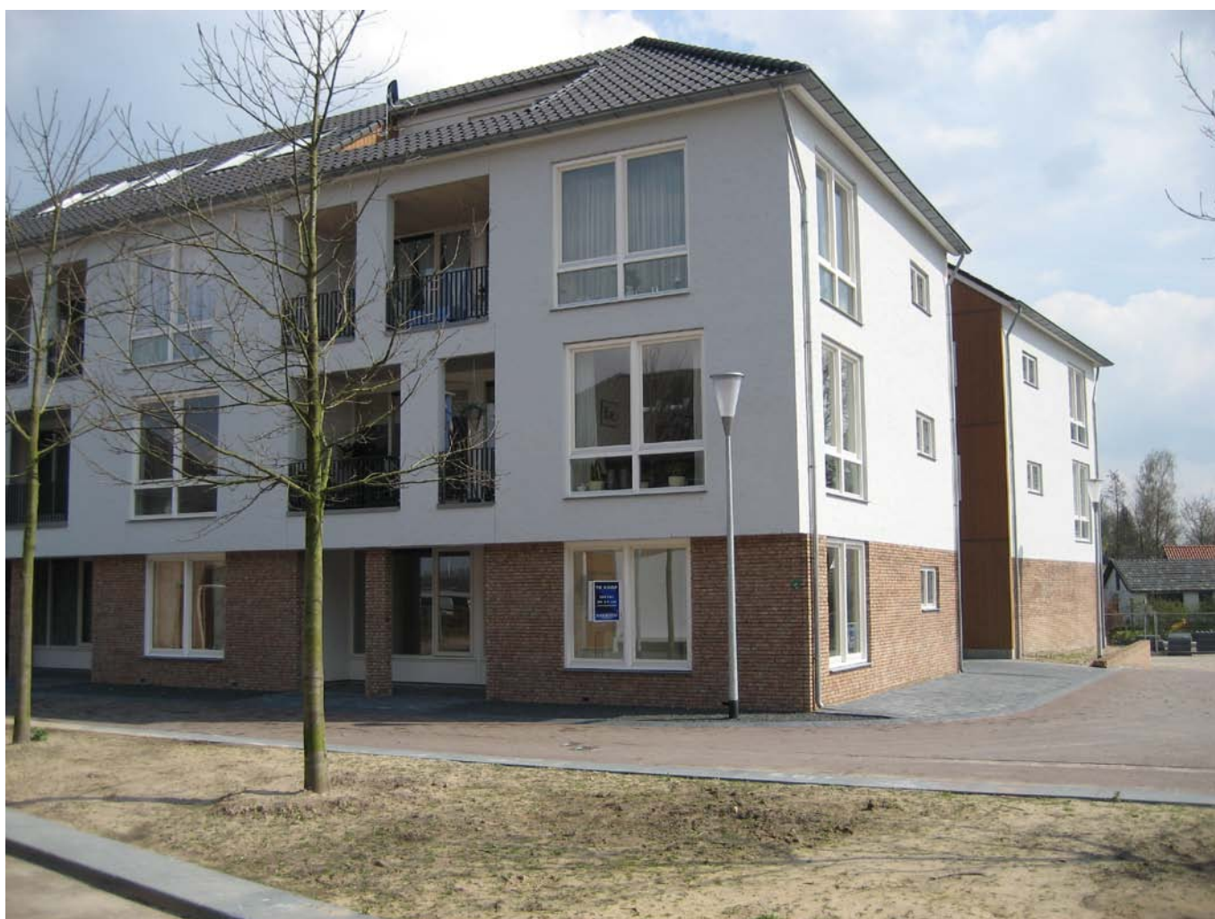
Duiven: Voorbeeld van geverfde buiten gevels.
