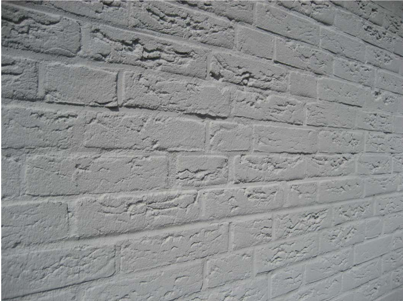
Duiven: Voorbeeld van een vrij ruwe steen met een aangepaste verf verwerking.
