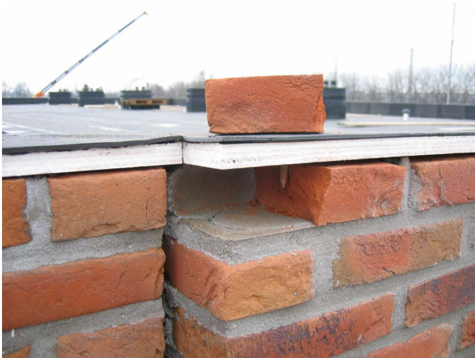
Utrecht: Verankering van de dakrand in het metselwerk m.b.v. pluggen.
