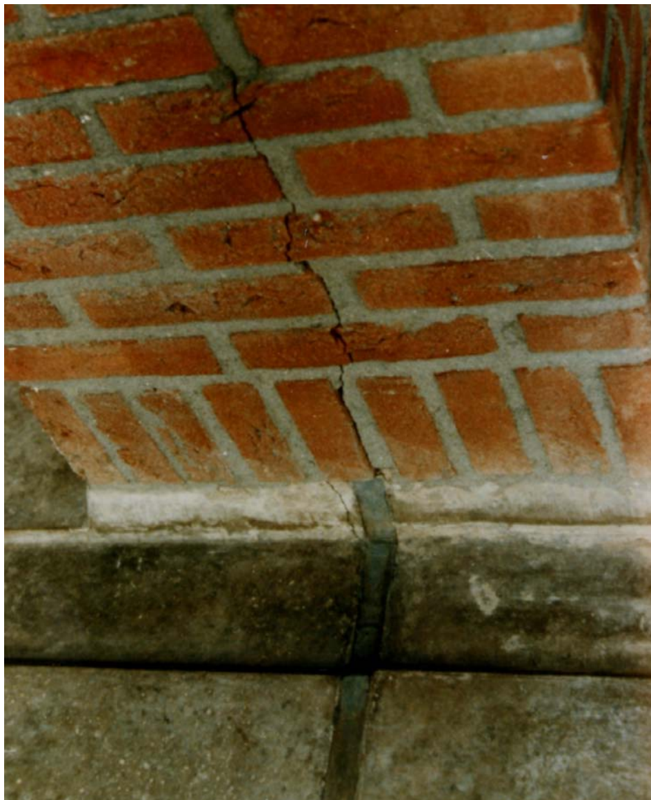
Dilatatie maken bij de overgang van de galerijplaten.
