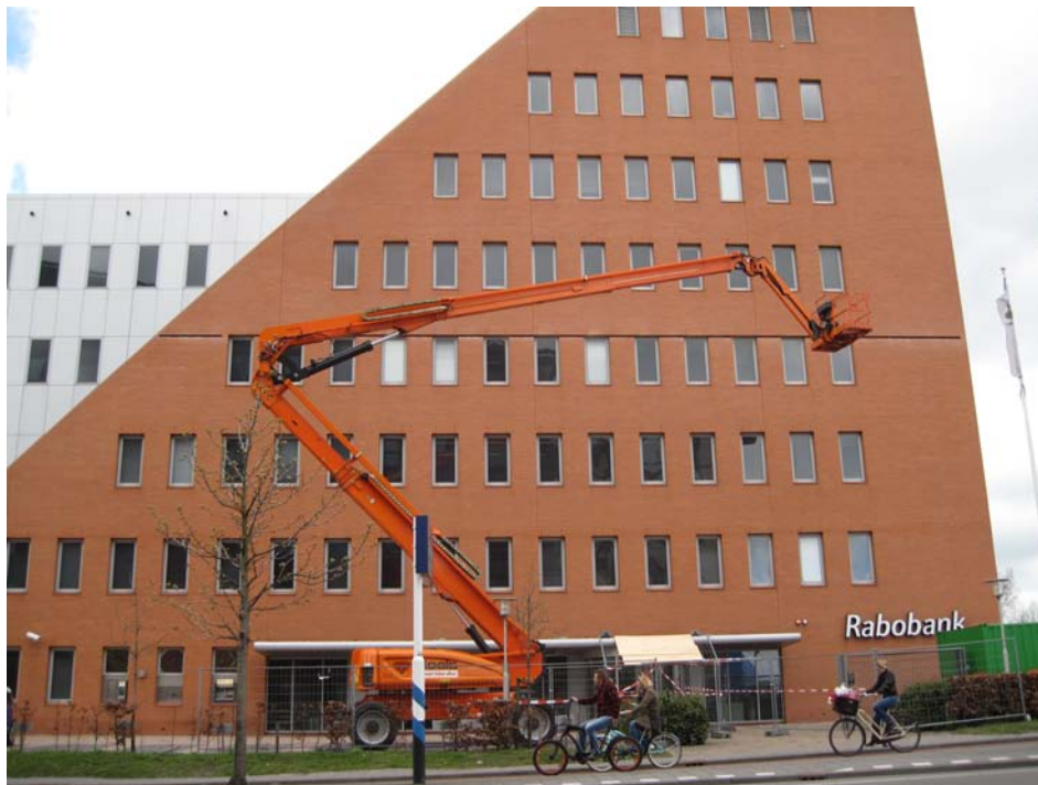
Groningen: Gevelherstel bij een muurdraagsysteem in de praktijk.
