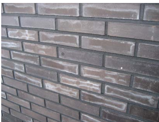
Typisch voorbeelden van sulfaat uitslag. (uit de stenen)
