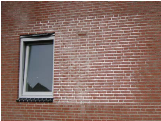
Typisch voorbeelden van kalkuitslag op de stenen en op de voegen. (uit de mortel)
