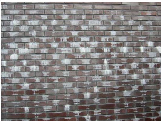
Typisch voorbeelden van kalkuitslag op de stenen en op de voegen. (uit de mortel)
