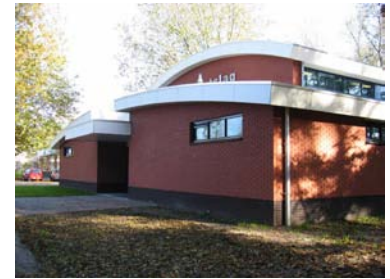
Foto 1 en 2: Emmeloord, gymzaal de zeevaarder: Lintvoegen 4-5 mm. terugliggend, glad (getrild met een trillijzer) met open stootvoegen van 7 mm.
