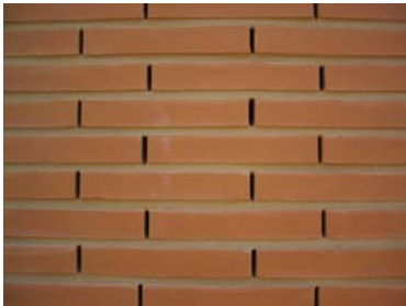
Foto 1 en 2: Emmeloord, gymzaal de zeevaarder: Lintvoegen 4-5 mm. terugliggend, glad (getrild met een trillijzer) met open stootvoegen van 7 mm.
