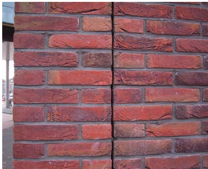
Dilataties goed open houden met behulp van een dilatatiemes en de bijbehorende klem. (Verhoeven Tools - Velddriel) en zorg ervoor dat het metselprofiel, d.m.v. een koppelprofiel los staat van het metselwerk.
