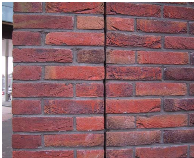
Dilataties goed houden met behulp van een dilatatiemes en de bijbehorende klemmen. (Verhoeven Tools - Velddriël)
