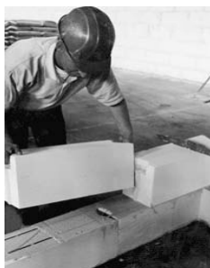
Evt. platte murfor toepassen.
