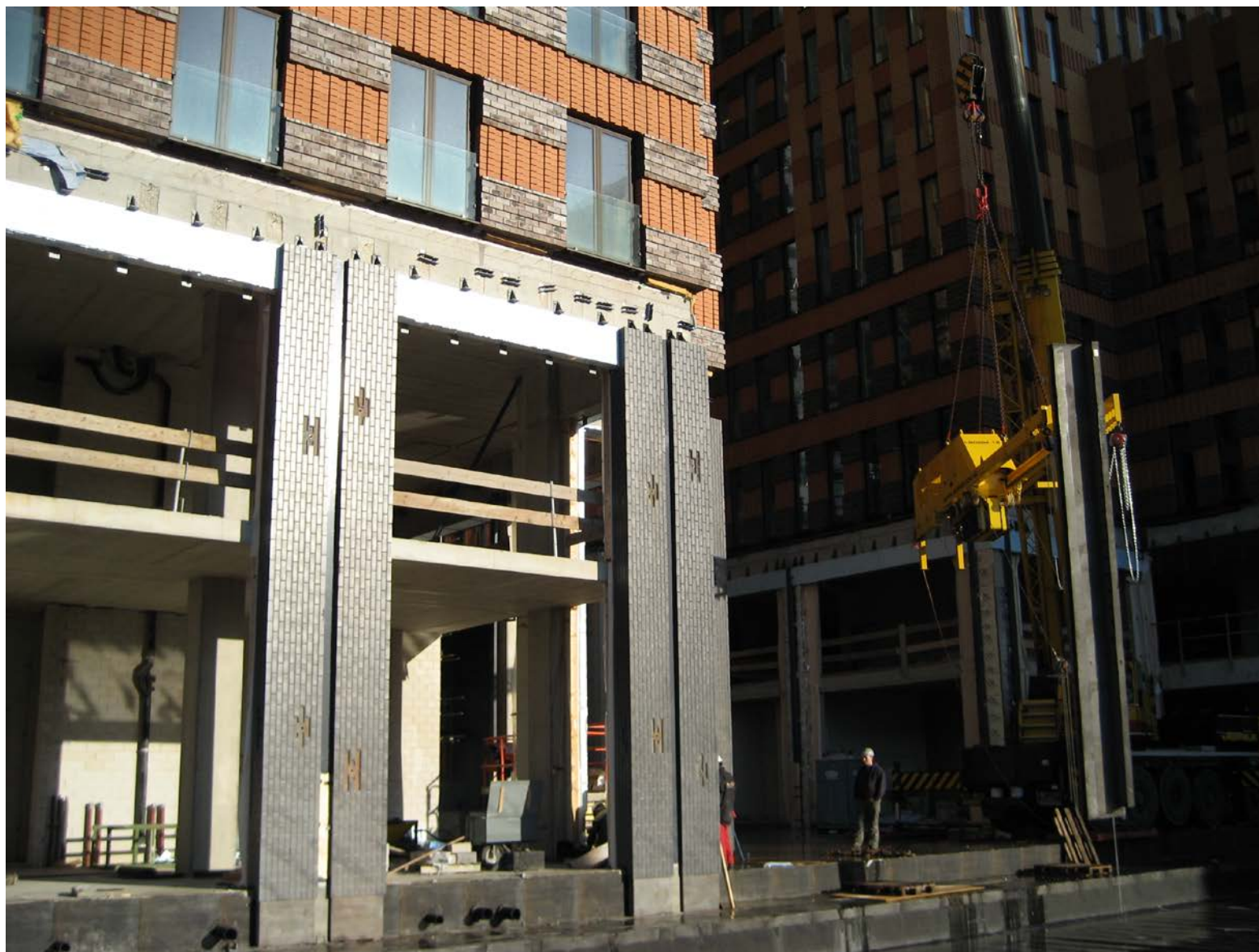
Project van de maand: oktober 2011 - Project van de maand: oktober 2011 - Project van de maand: oktober 2011 - Project van de maand: oktober 2011
