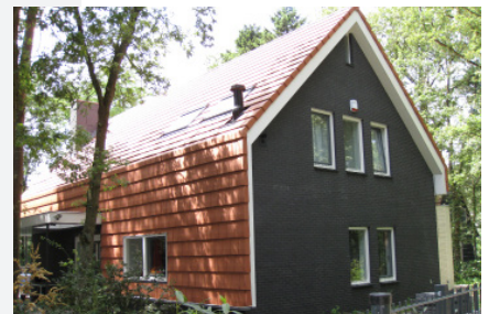
Foto 1: Voorbeeld van een verticale dakpangevel
