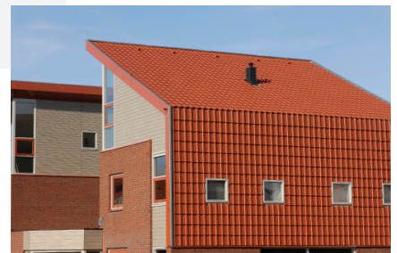
Foto 2: Voorbeeld van een verticale dakpangevel
