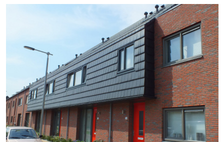
Foto 3: Voorbeeld van een verticale dakpangevel
