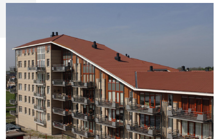
Foto 2: Voorbeeld van een flauw hellend dakvlak
