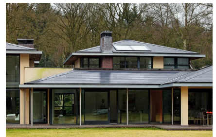
Foto 3: Voorbeeld van een flauw hellend dakvlak
