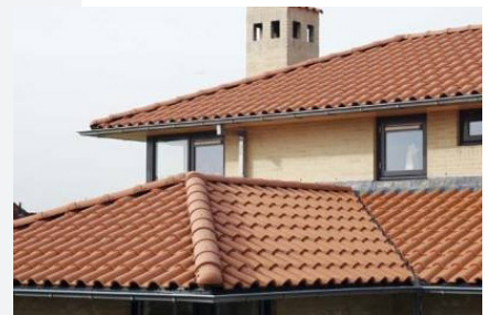
Foto 1: Voorbeeld van een flauw hellend dakvlak
