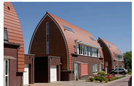
Foto 2: Voorbeeld van een gebogen dakvlak
