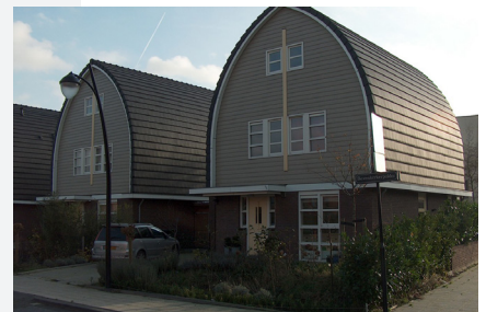
Foto 1: Voorbeeld van een gebogen dakvlak
