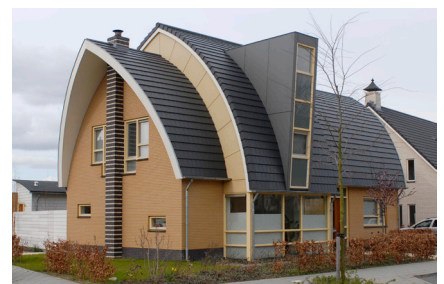
Foto 3: Voorbeeld van een gebogen dakvlak
