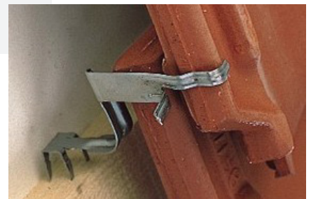
Foto 2: voorbeeld van een dakpanverankering
