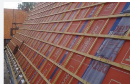
Foto 1: Uitzetten panlatten
