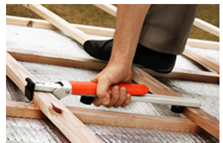
Foto 3: Voorbeeld van een hulpstuk bij het uitzetten van de panlatten
