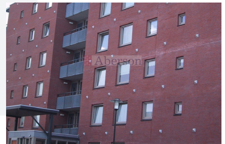
Foto 3: Appartementengebouw met een niet stabiel casco: hoogte kan meestal worden genomen op 3e verdieping en daarboven om de 2 verdiepingen.
