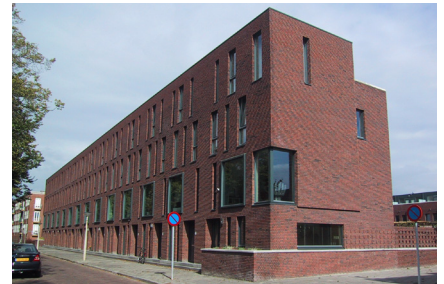
Foto 1: Groningen Pioenstraat: Geen geveldrager bij 4 verdiepingen
