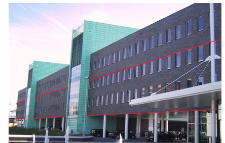
Foto 4: Almere, Pricewaterhousecoopers: Na de eerste geveldrager om de 2 verdiepingen een geveldrager
