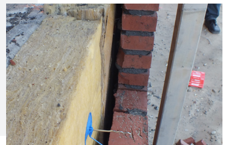
Foto 2: Voorbeeld van een open spouw met isolatie
