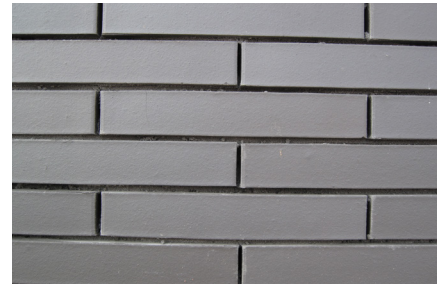
Foto 4: Deventer kantoor: 5 mm verdiept, grijze dunbedmortel
