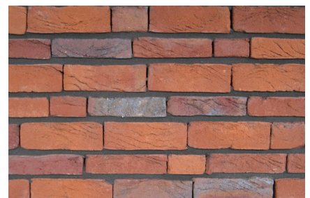
Foto 3: Rotterdam Crooswijk: Brede school: 10mm verdiept, doorstrijkmethode, antraciet
