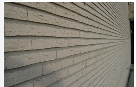
Foto 1: Tilburg: basisschool Leybeemd: Benadrukken van de horizontale belijningen
