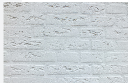
Foto 3: Den Bosch, woningen Boschenveld: Voorbeeld van een vrij ruwe steen met een aangepaste verf verwerking
